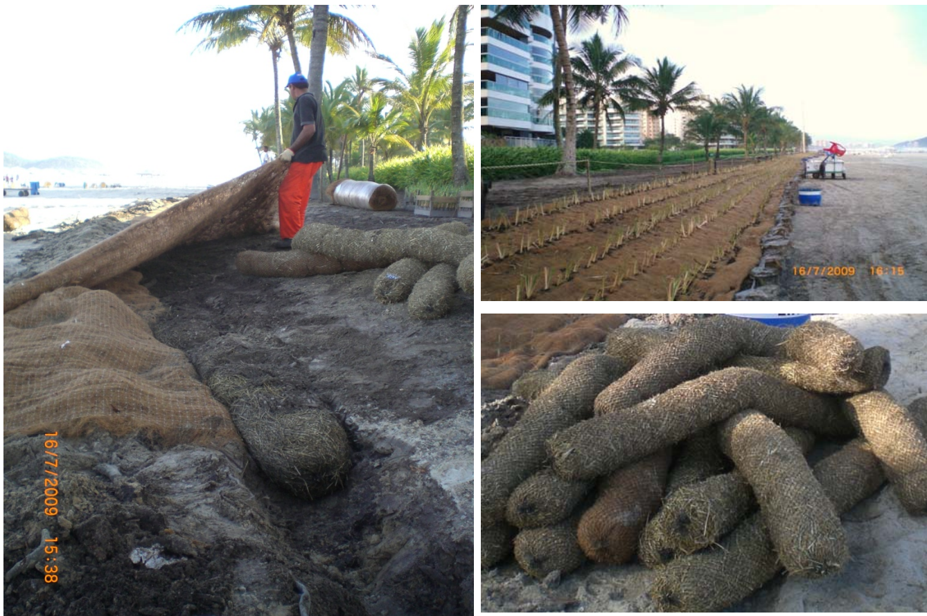
图4： 安置沉积物滞留器和椰子纤维侵蚀控制毯（左），最终的项目实施：木栅栏，侵蚀控制毯和香根草篱（右上），沉积物滞留器（右下）
