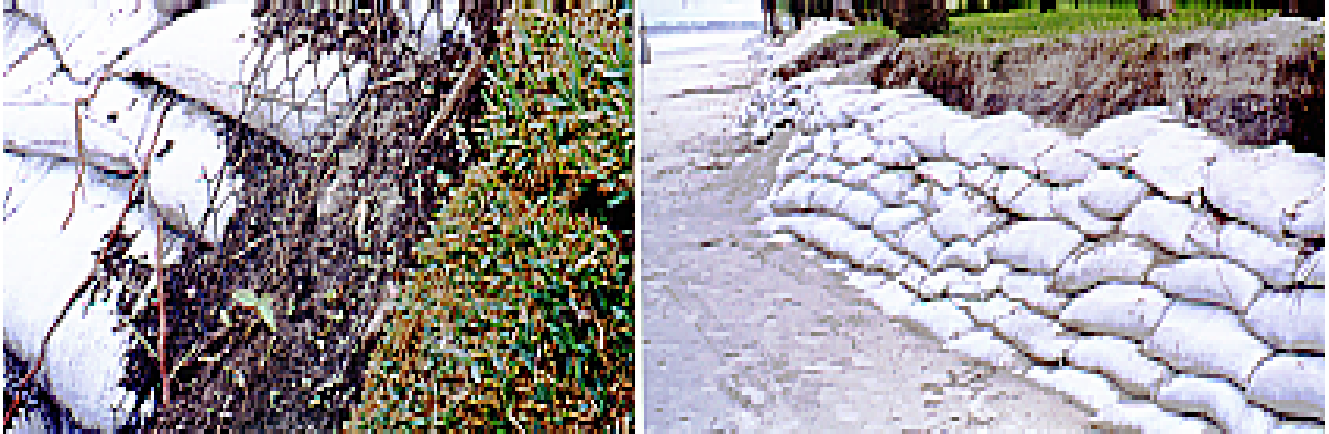
图 2 用沙袋抵御海潮侵蚀: 最初的控制侵蚀措施
