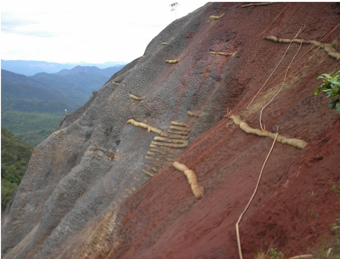
Foto 1: Descomissionamento de mina: tratamento de encostas com as técnicas de Bioengenharia de Solos.
